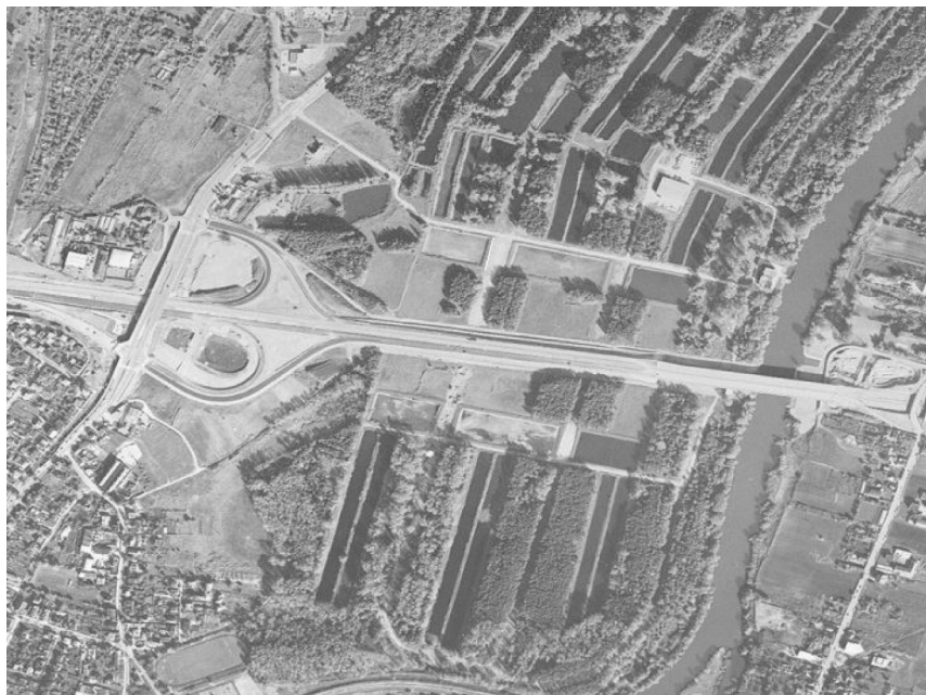
Rys.1. Fragment ujęcia wody Dębina w Poznaniu przeciętego autostradą A2
